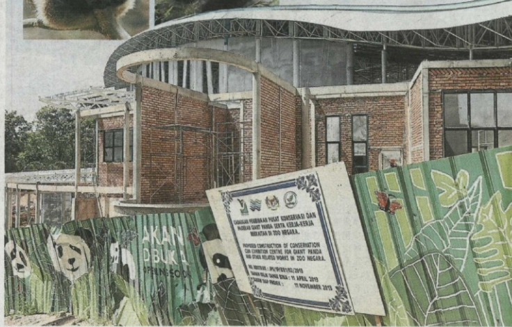
熊猫馆的工程进度已届70%，建筑工地上可看到基本结构及蓝色圆形的屋顶。 小图:在四川时，凤仪(左)看不上福娃(右)。
