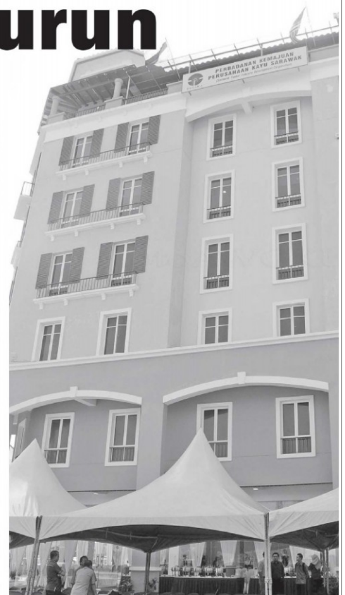
TERSERGAM INDAH ... Bangunan PUSAKA Pejabat Wilayah Utara, di Marina Square, di Miri.
