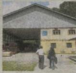
合板研究工作室建造于 1980 年代早期，柱子所使用的木材种类是红巴杜柳桉 (Red balau)。该建筑具有 21 米净间距和 7 米间隙高度，是园内最大的木建筑。颜博士自豪地说：“这座建筑物拥有超过 25 年历史了，依然那么稳固和结实！”
