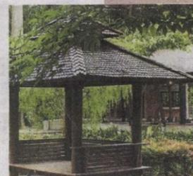
在瀑布区域的椰子棕榈木凉亭位于瀑布附近。凉亭屋顶的结构、柱子、围栏、地板和梯级都是由棕榈木制成，这意味着除木材之外，也有其他替代材料可以用于建筑。凉亭的立柱被置于混凝土板上，以避免与土壤直接接触以及降低被昆虫和真菌侵染、吸收水分的风险。
