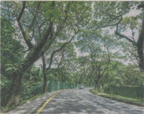
KEGAGALAN kerja-kerja mencantas dahan pokok oleh pihak berwajib mengundang bahaya kepada pengguna setiap kali melalui Jalan Semerah Padi, Cheras, Kuala Lumpur.
