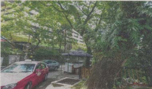
KEADAAN pokok yang berpotensi untuk tumbang dan reput pada bila-bila masa di sekitar bahu jalan Apartmen Cheras Ria, Kuala Lumpur.
